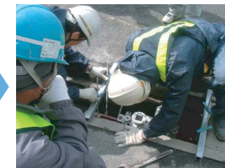
カッター専用ジグによる レール及び架台の設置
