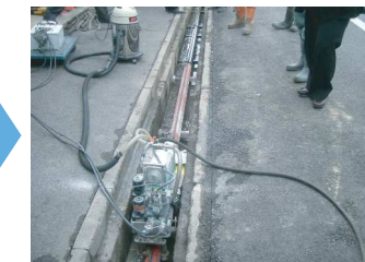
切断 1ステップ目 11"ブレードにて5cm深さ
