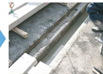
敷きモルタルの貼付
