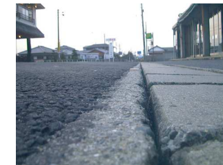
施工前水路状況
