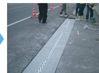
側溝蓋設置風景
