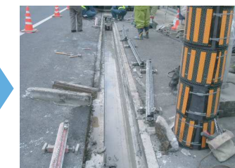
レール取り外し・切断部撤去
