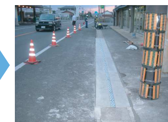
仕上がり (影響部のモルタル充填)
