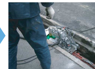
カッター本体の設置
