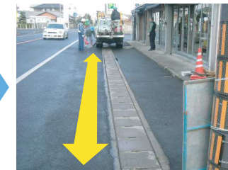
施工前水路状況 施工区間10m
