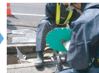
ブレードの取り替え 11"→15"
