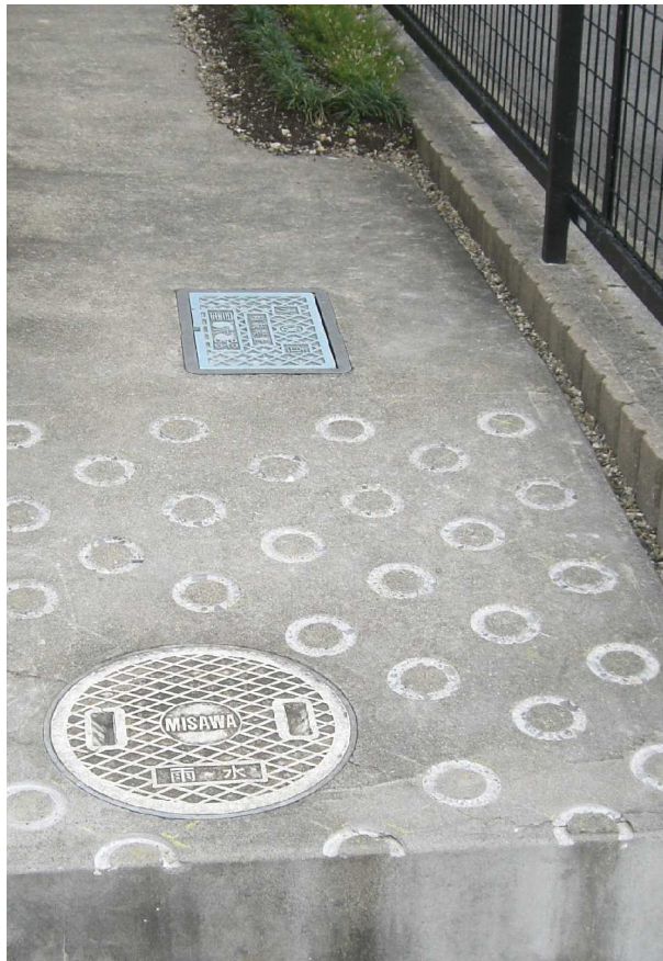
コンクリート施工
