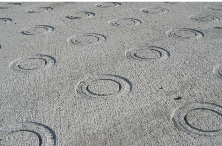
ダブルタイプ施工
